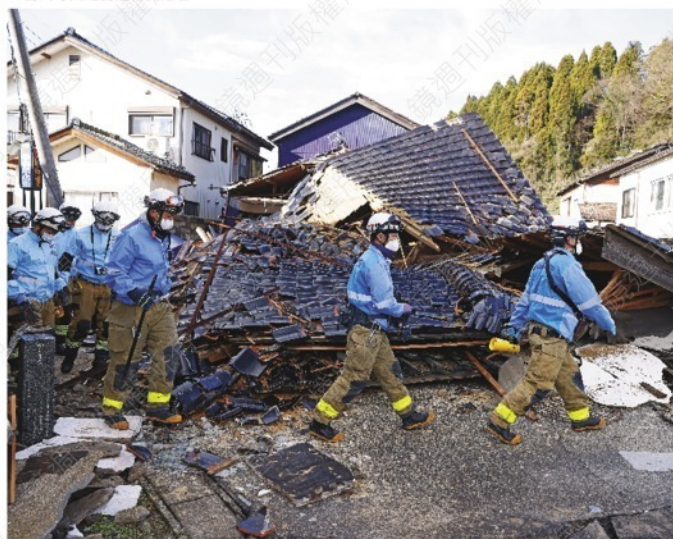
↓珠洲市災情嚴重，救災人員正從倒塌屋頂嘗試尋找是否還有受難者。
